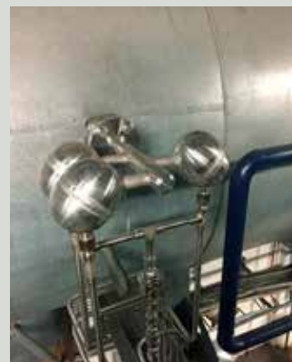
Her har vi lavet en flowmåling i en kanal ved hjælp af en differenstrykmåling over et midlende pitotrør. Vi har ligeledes stået for instrumenter samt fremstilling af instrumentstativ og mekanisk montage
