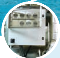
Kabinettet her er placeret i maskinrummet, og opsamler signaler fra de installerede instrumenter og videresender til broen.
