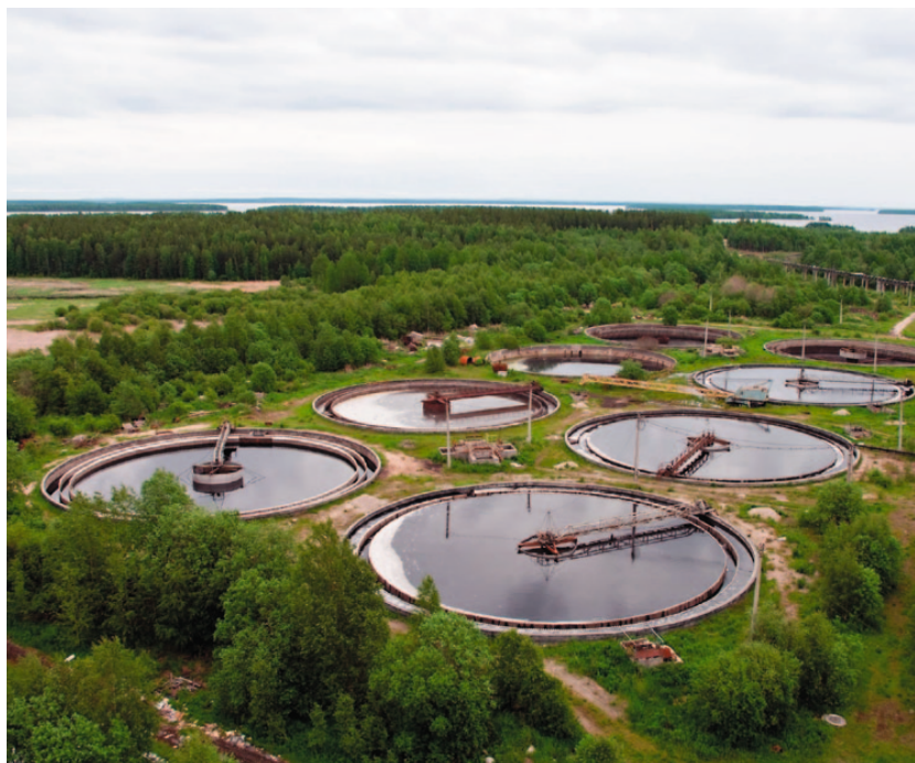
Rensningsanlæg i Tyskland
