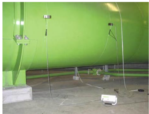
Ultralydsflowmåler - Clamp-on
