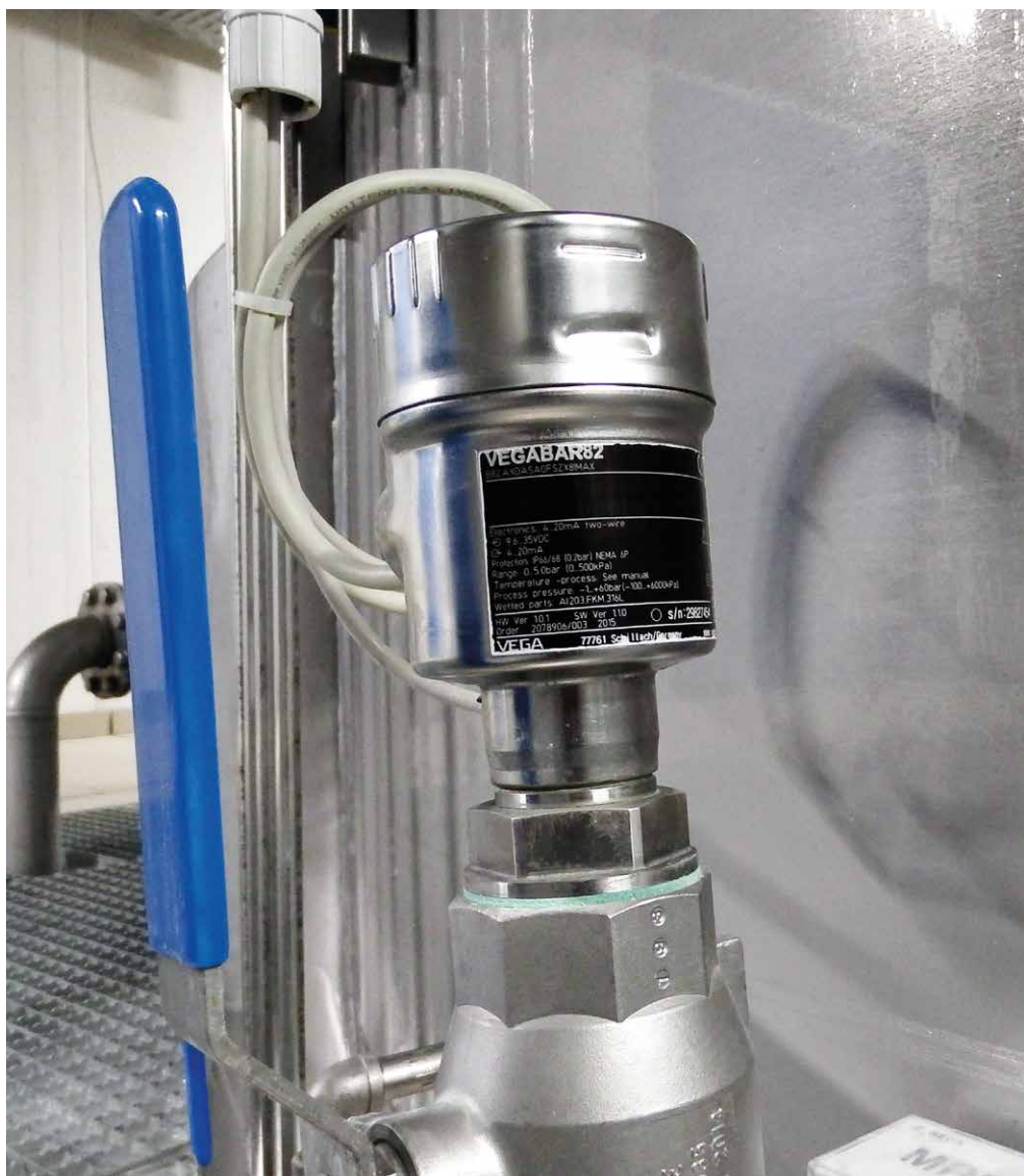
Målepunkt med VEGABAR 82 og "Second Line of Defense".
