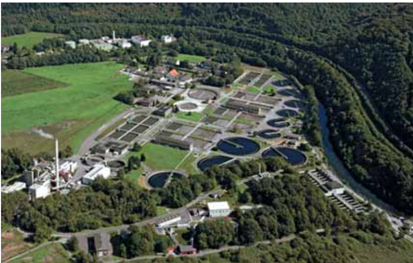
Buchenhofen rensningsanlæg ligger i et 812 km 2 stort område, nær Düsseldorf, der alt sammen afvandes til Wupper floden. Det offentlige ejede firma, Wupperverband, driver i alt 11 rensningsanlæg i området hvor Buchenhofen er det største.
