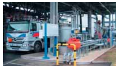
Tankfarm for lastbiler med flere forskellige produkter, herunder også additiv tilsætning.
