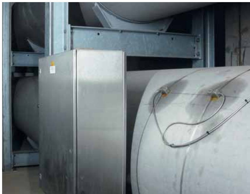
Clamp-on transducerne monteres nemt og hurtigt med de tilhørende spændebånd. De kan sågar monteres under drift.
