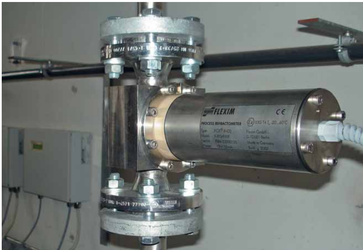
Refraktometer monteret i standard T-stykke til flangemontering.
