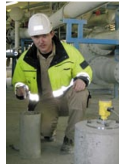
Leo Korsgaard lyser ned i silo, for at se hvor meget det støver. Radar er placeret i den gamle studs fra silopilot.
