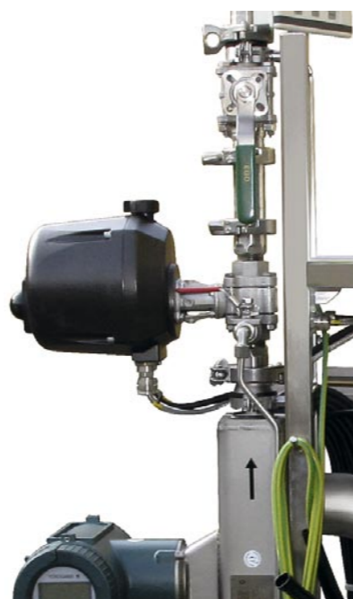
Reguleringsventil til korrekt dosering af batch størrelse under varierende procesbetingelser
